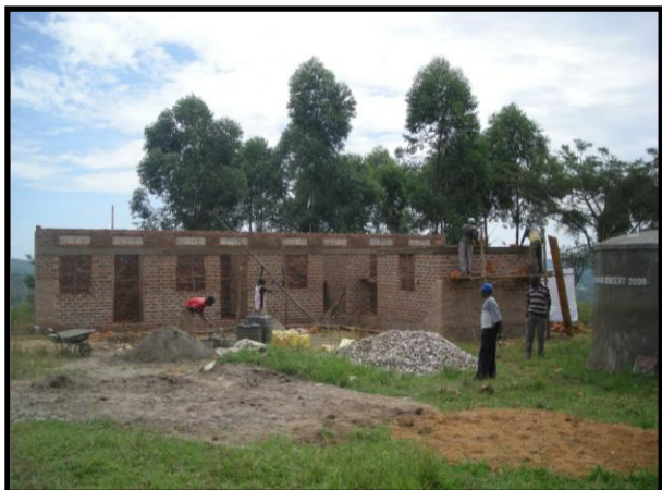
スタッフルーム建設中
